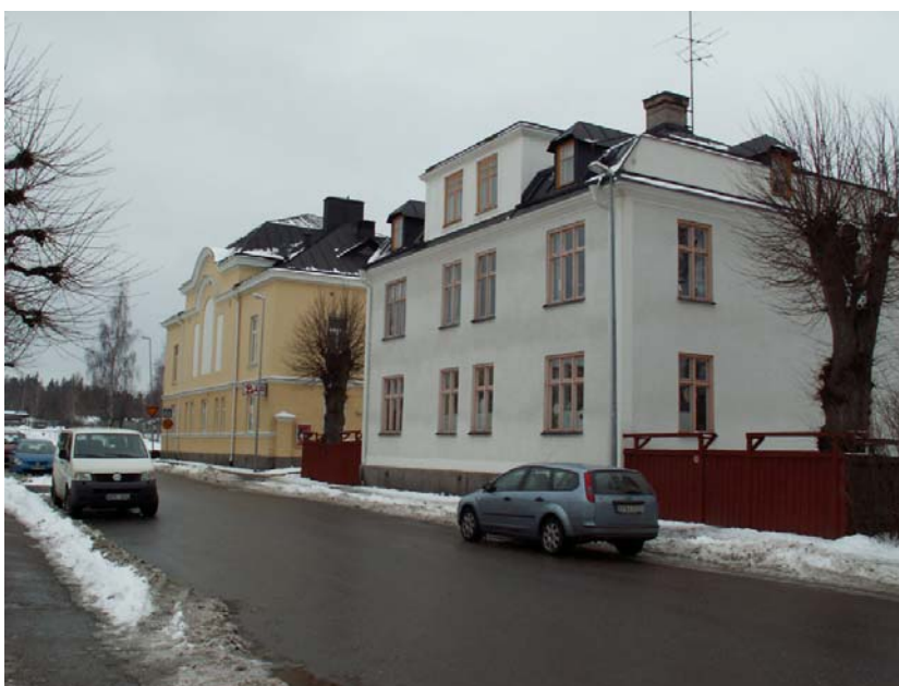
Byggnader vid Nygatans nordöstra del
